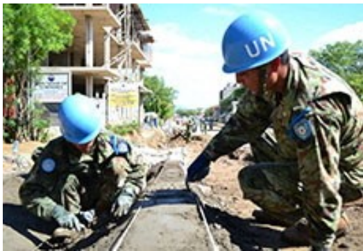
南スーダンにおける道路整備 * 陸上自衛隊 HP より引用
